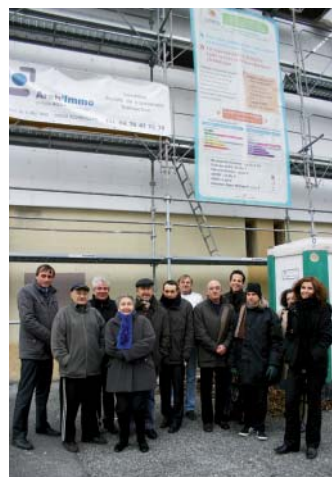
Visite de la copropriété La Bruyère, en cours de travaux.
